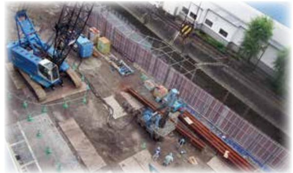
矢板を地中に打設して、地盤を掘削する際に周囲の地盤が崩れないようにするための工事
