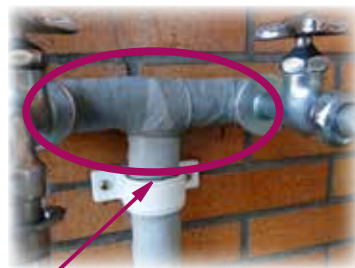
（例）水道管に保温材などを巻き付け、濡れないようにテープで保護する
