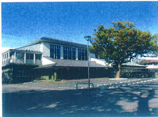
島原市霊丘公園体育館・弓道場
