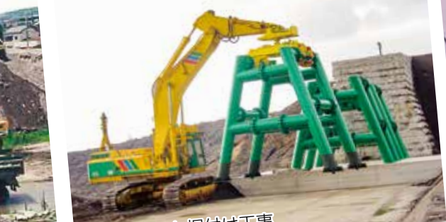
鋼製スリット据付け工事
