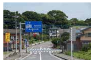
⑥新湊工区（市道 新湊大下線付近）
