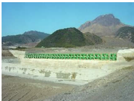
砂防ダム（スリットダム）
