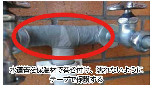
水道管を保温材で巻き付け、濡れないようにテープで保護する
