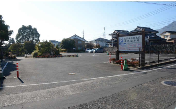
武家屋敷駐車場舗装等撤去工事箇所
