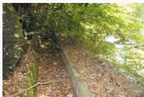
発電用に水を引くための導水路
