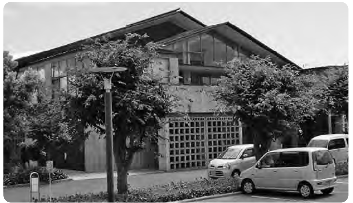
▲条例の一部が改正された有明福祉センター
