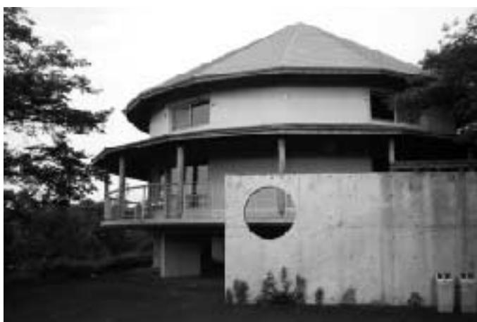
▲活用が期待される有明の森運動公園管理棟
