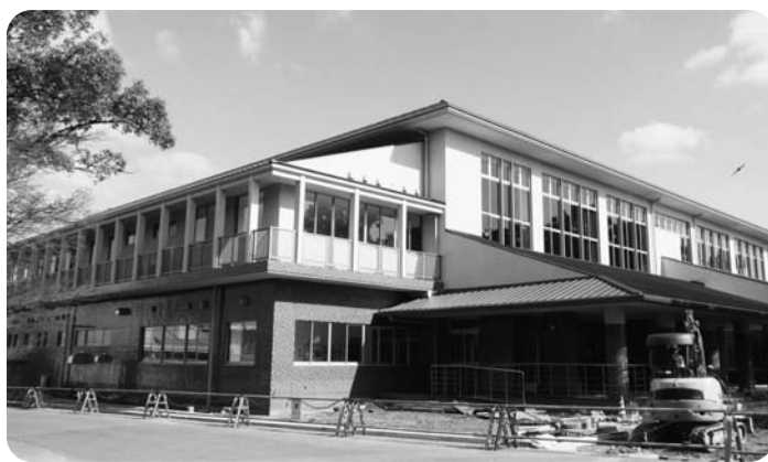
▲完成間近の霊丘公園体育館・弓道場
