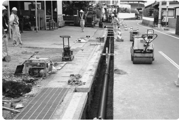
▲水道管布設がえ工事のようす（有明町大三東地区）
