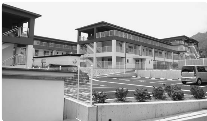
▲建てかえ工事が進む萩が丘住宅
