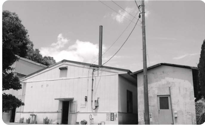
▲現在、灯油を使用して源泉を加温している給湯所
