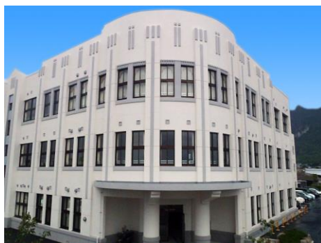
第三小学校（新築校舎）
