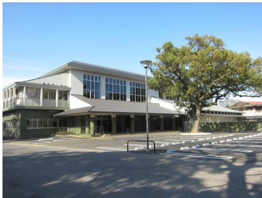
島原市霊丘公園体育館・弓道場
