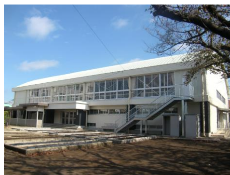
第一小学校体育館（非構造部材）
