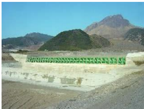
砂防ダム（スリットダム）
