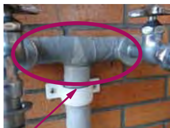
水道管に保温材などを巻き付け、濡れないようにテープで保護する(例)
