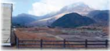
かさ上げ工事が実施されている水無川流域
