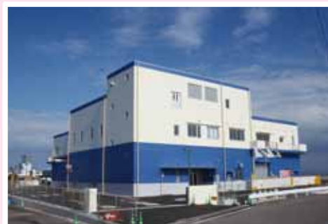
運転開始に向けて「し尿処理施設」の建設を進めています
