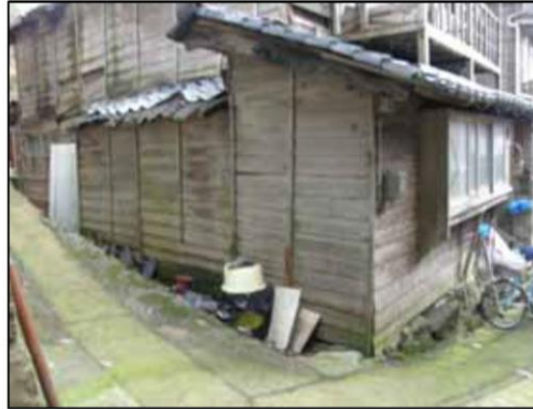
外壁が裸木造の例
