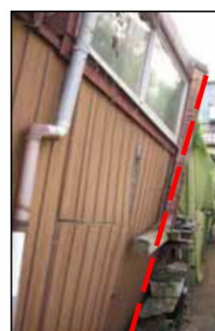
柱の変形が著しく崩壊の危険がある例
