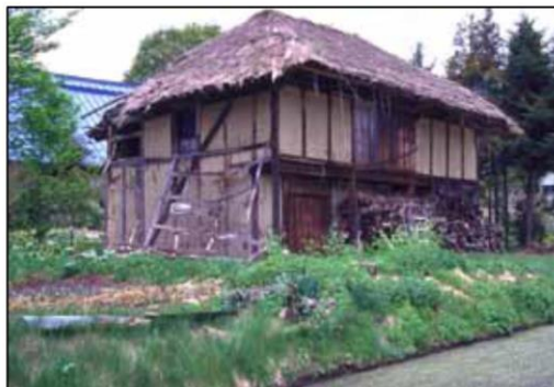
屋根材がワラの例
