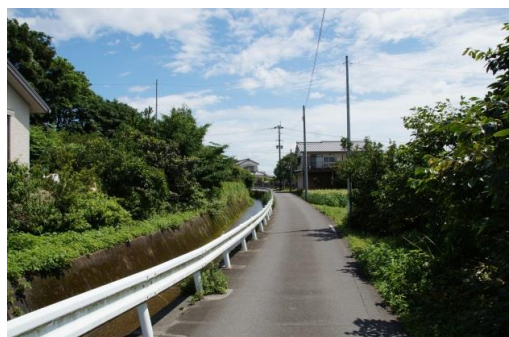
幅員狭小市道(南下川尻町)
