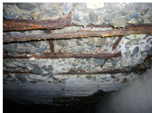
都市下水路内を撮影 コンクリート床板内の鉄筋が腐食し、破損している状況
