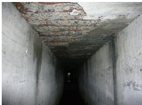
都市下水路内を撮影 コンクリート床板内の鉄筋が腐食し、破損している状況
