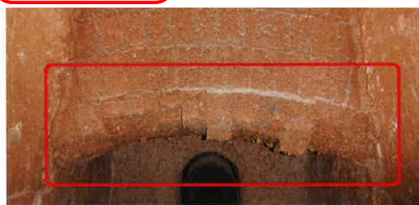
主燃焼炉【排煙吸込口下がリアーチ】
