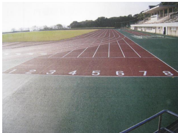
【陸上競技場改修工事】
