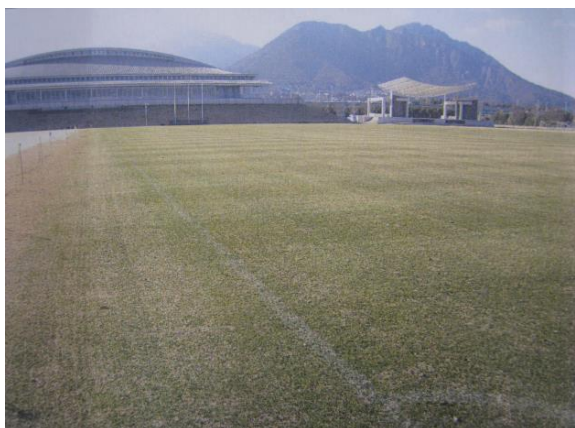
【平成町多目的広場オーバーシーディング工事】
