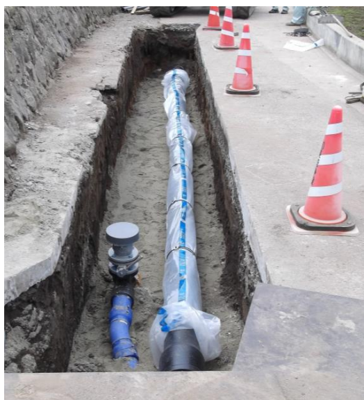
配水管布設替工事
