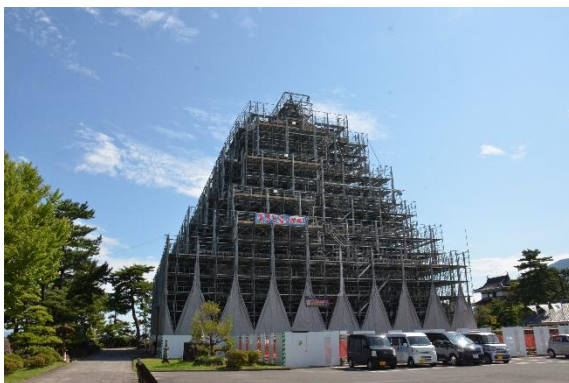
島原城天守閣外壁等改修工事
