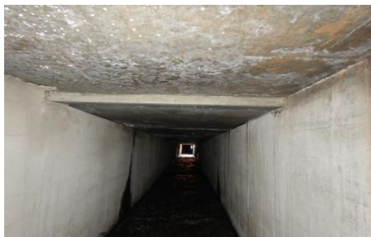
補強・補修完了後
