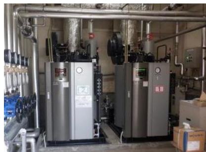
有明学校給食センター ボイラー更新工事
