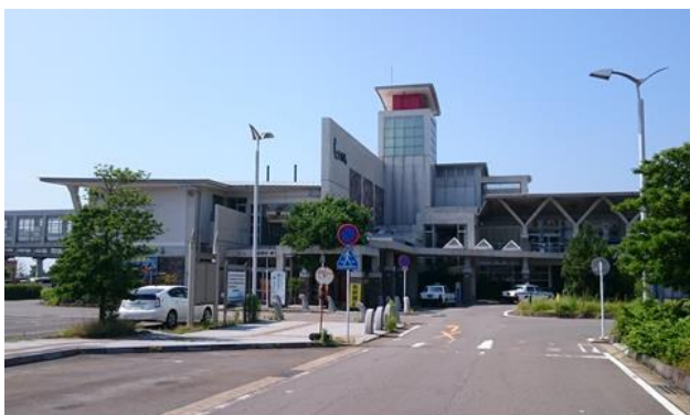
<島原市の海の玄関口 島原港ターミナルビル>
