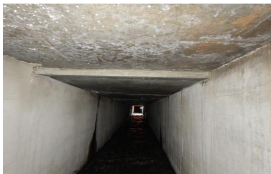
補強・補修完了後
