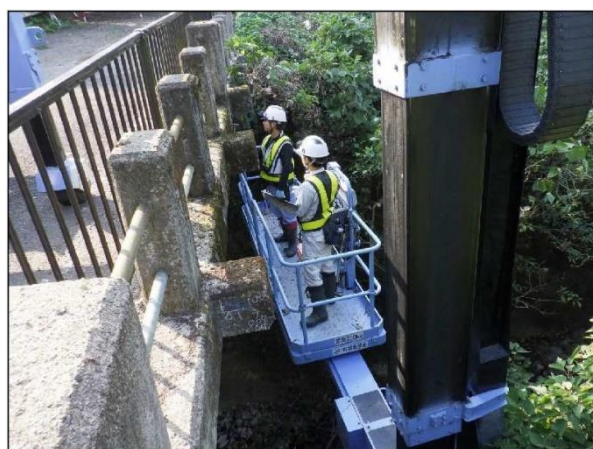
橋梁点検状況
