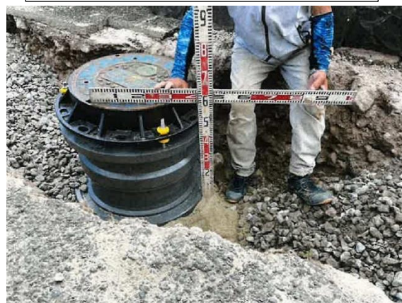
【上の原 20 号線配水管布設替に伴う消火栓工事】
