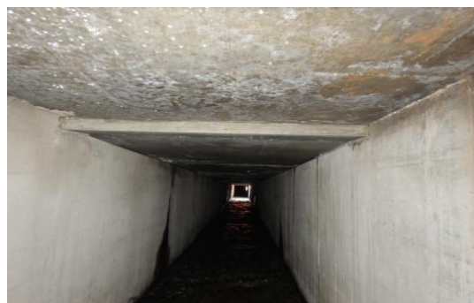
補強・補修完了後
