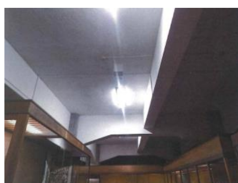
島原城天守閣照明器具改修工事（完了）
