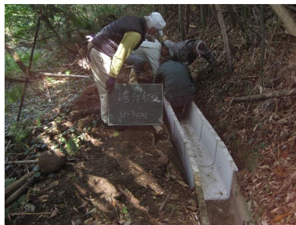
水路の改修の状況
