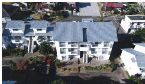
柏野住宅（改修後）
