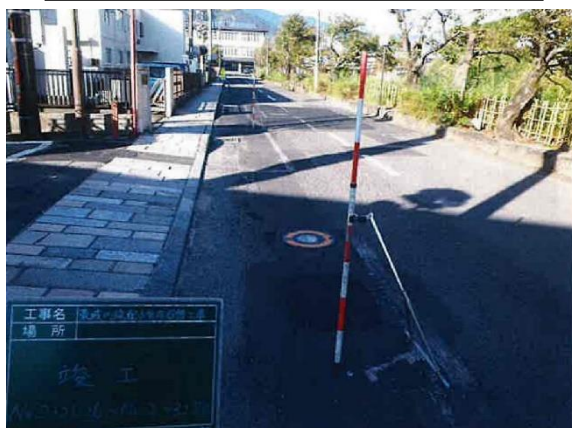
【東城内線配水管布設替に伴う消火栓工事】
