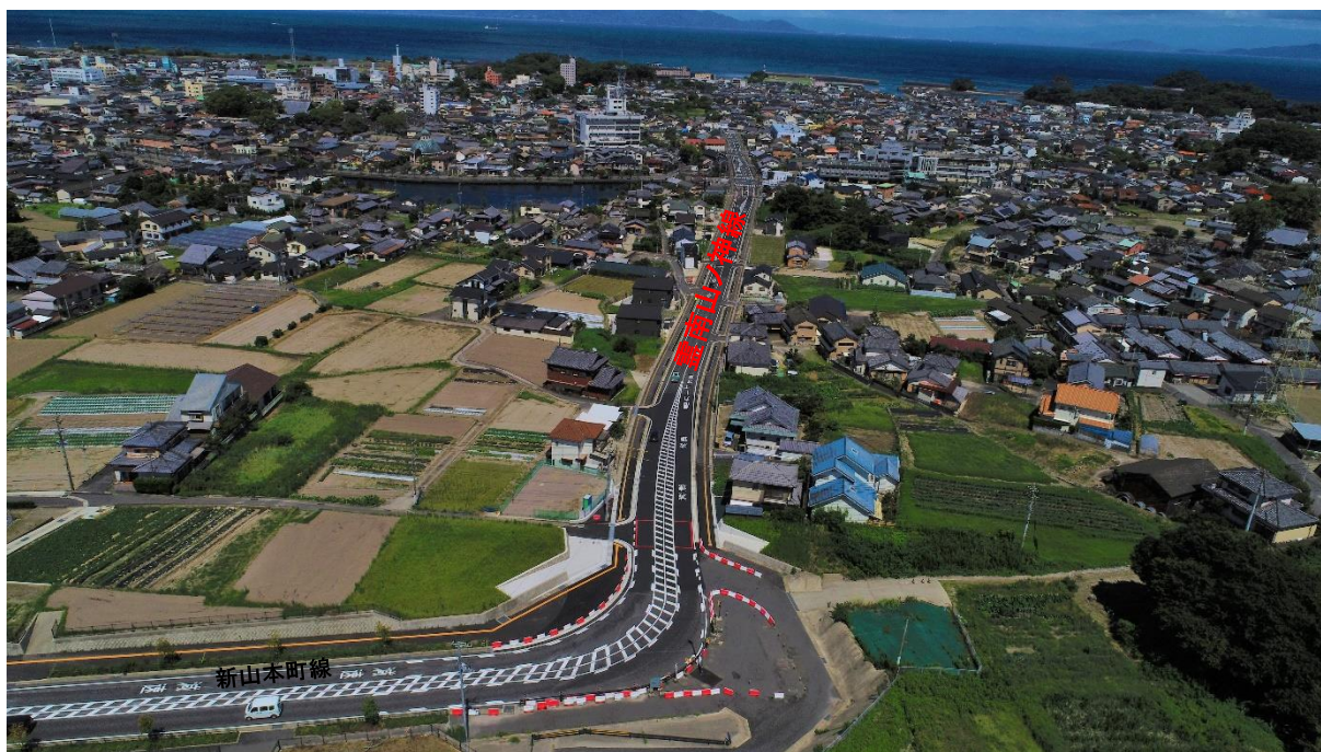
整備状況（令和 6 年 3 月）
