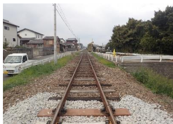
レール交換（湯江駅～大三東駅間）
