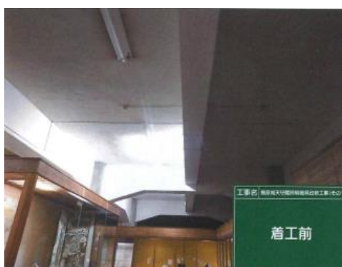
島原城天守閣照明器具改修工事（着工前）
