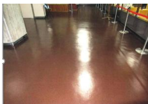
島原城床改修工事（完了）
