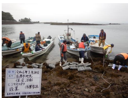
島原地区ヒジセラポラ設置
