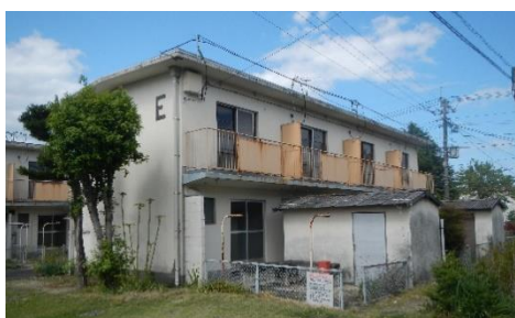
桜馬場住宅E棟（解体前）
