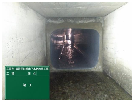
管渠更生完了後
