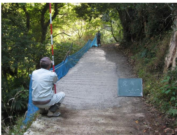
農道路肩の補修の状況
