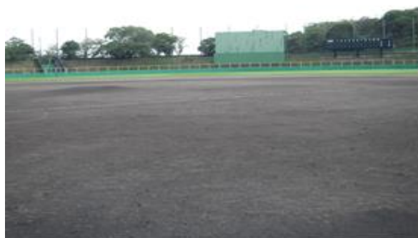
【市営球場グラウンド整備工事】
