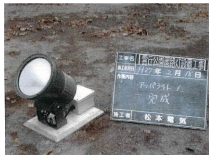
(樹木照明灯設置)
