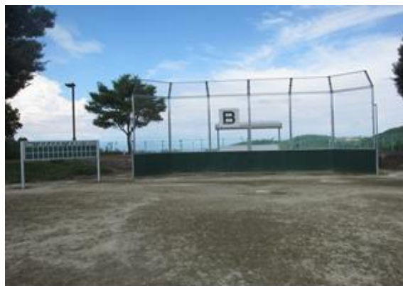
【三会ふれあい運動広場バックネット設置工事】
