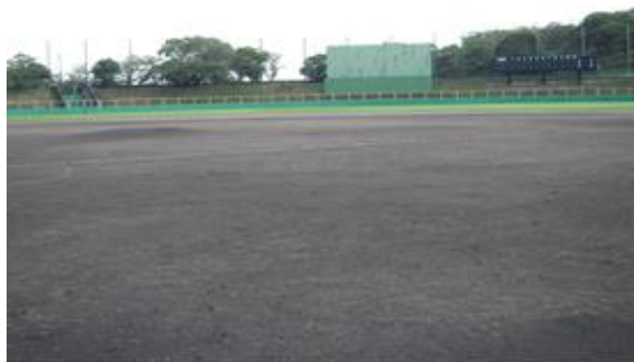
【市営球場グラウンド整備工事】
