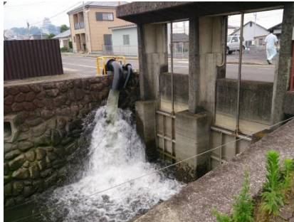
(海側) 排水状況
