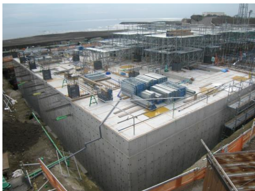
地下躯体工事完了
