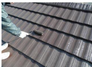
屋根瓦：断熱塗料によるリフォーム
