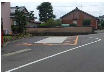
第 23 分団管轄防火水槽
