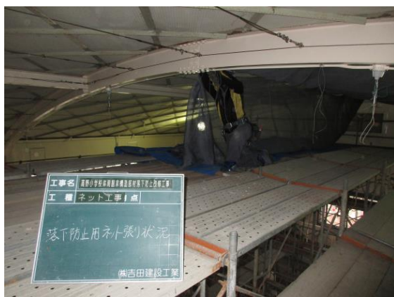
(天井ネット設置工事)
