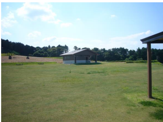
広場造成工事
