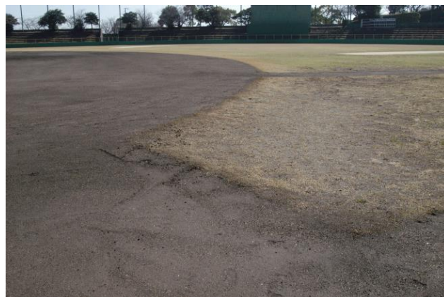
【市営球場芝張替工事】
