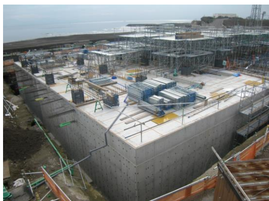
地下躯体工事完了
