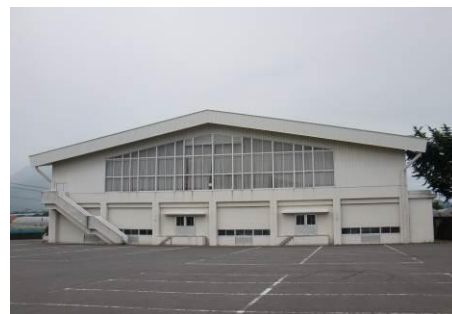
<有明農業者トレーニングセンター>
