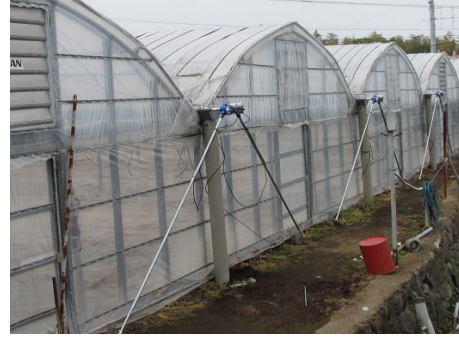
〔自動換気施設〕
