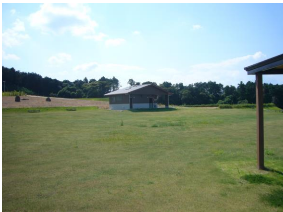
広場造成工事
