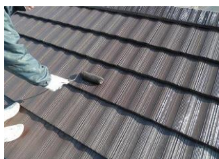
屋根瓦：断熱塗料によるリフォーム
