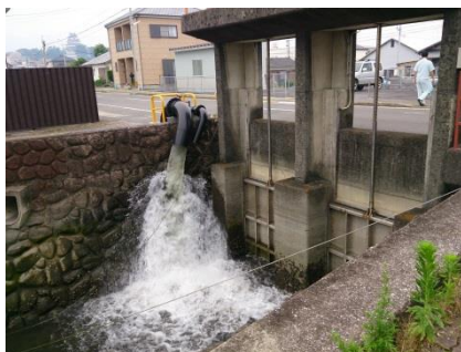
(海側) 排水状況
