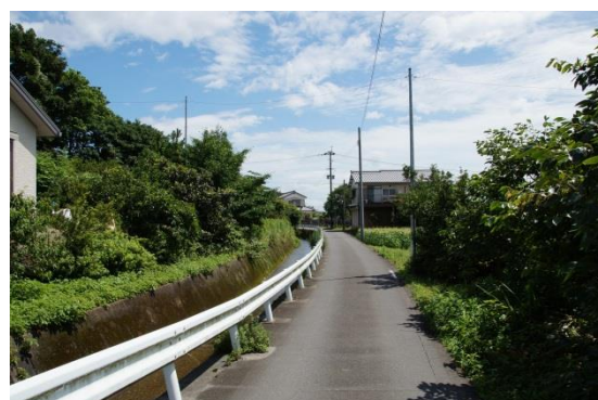
現況幅員狭小市道（南下川尻町）
