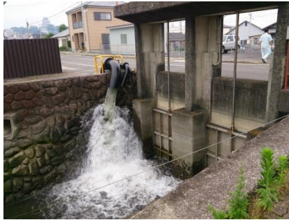
(海側) 排水状況
