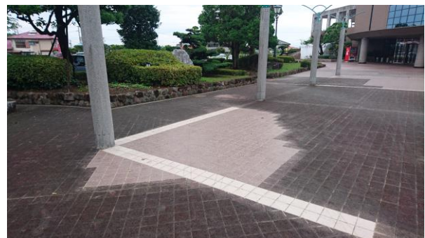
<外構タイルの修繕>
