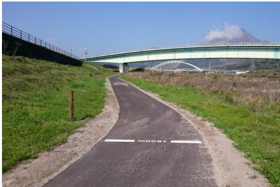
<平成28年度整備区間>
