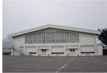
<有明農業者トレーニングセンター>
