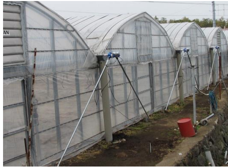
〔自動換気施設〕
