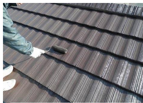
屋根瓦：断熱塗料リフォーム抜粋
