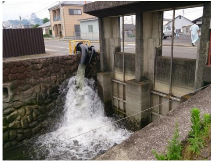
(海側) 排水状況
