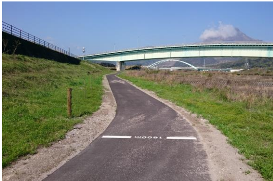
<平成28年度整備区間>
