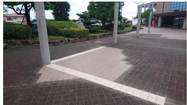
<外構タイルの修繕>
