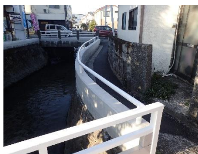
嵩上状況 (有明橋付近)
