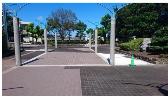
<外構タイルの修繕>
