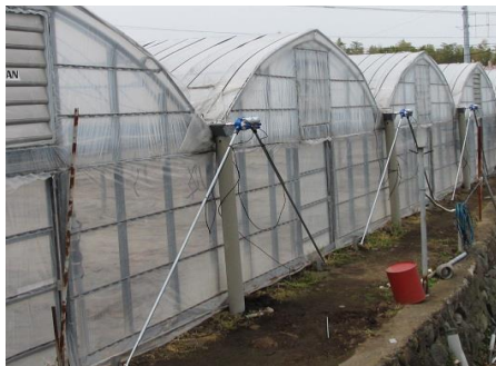
[自動換気施設]
