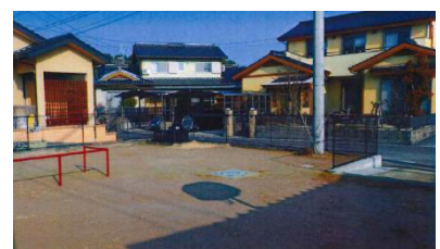
第16分団管轄防火水槽
