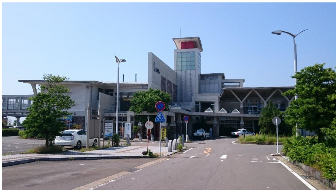
<島原市の海の玄関口 島原港ターミナルビル>
