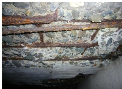
鉄筋露出腐食状況
