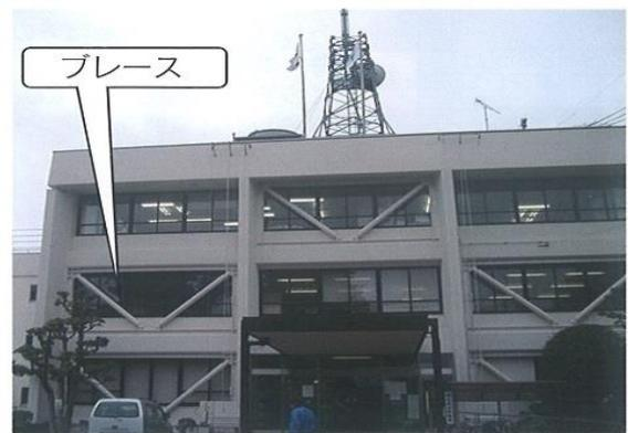
★ブレースを設置し、建物の強度を高め耐震性の向上を図る。
