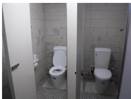
<屋外トイレ洋式化改修工事>
