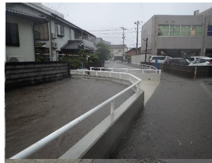
浸水被害防止状況（H30.6.29）
