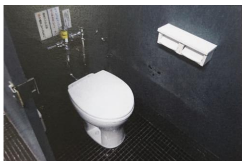
大ホール女子トイレ洋式化改修工事
