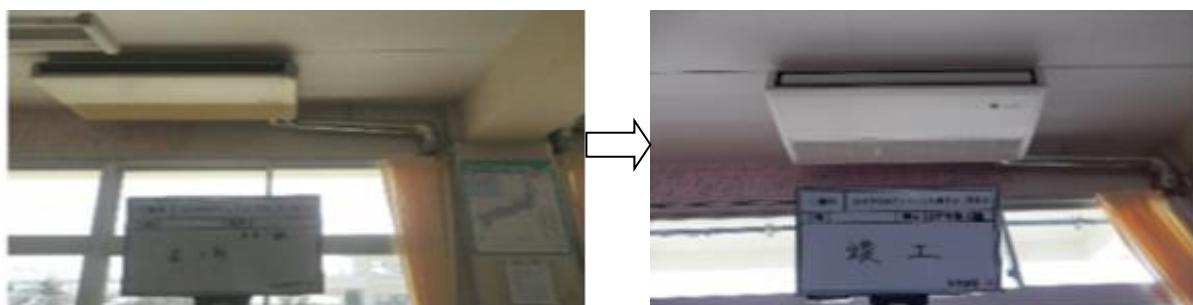
<第三中のエアコン更新工事>
