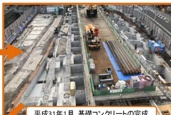
平成31年1月 基礎コンクリートの完成
