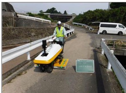
地中レーダ探査状況
