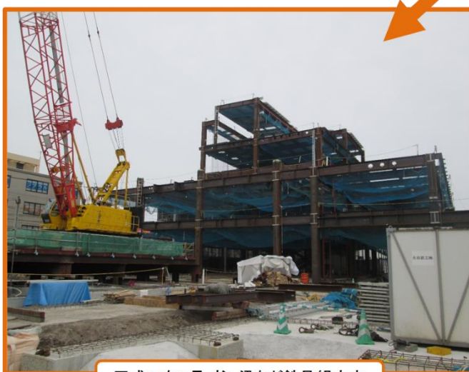
平成31年3月 柱・梁など鉄骨組立中
