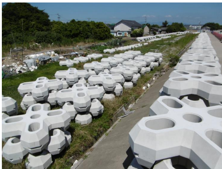
防砂堤 被覆ブロック
