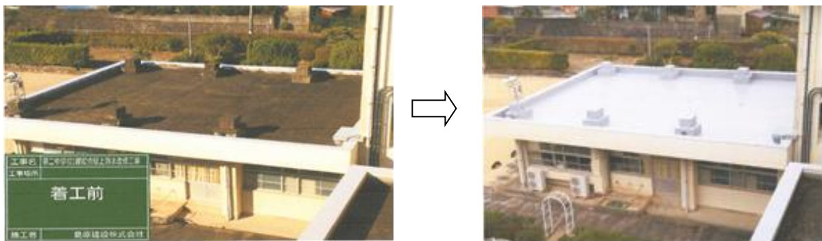
<第二中2棟校舎屋上の防水改修工事>
