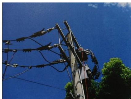
高圧区分開閉器取替
