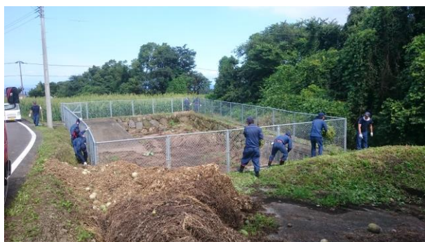
沈砂池の適正管理状況
