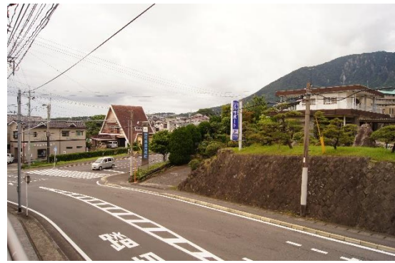
下川尻工区(島原病院入口付近)
