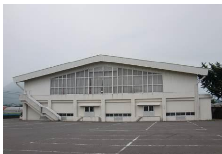
<有明農業者トレーニングセンター>
