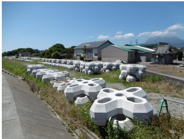
防砂堤 被覆ブロック
