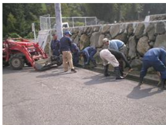
水路の泥上げ状況
