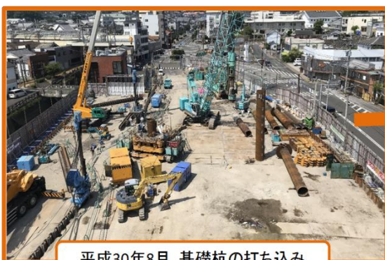
平成30年8月 基礎杭の打ち込み
