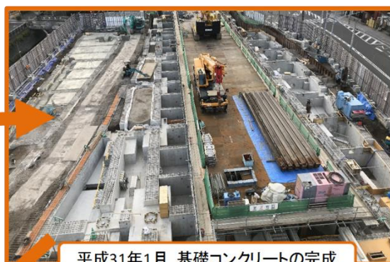
平成31年1月 基礎コンクリートの完成
