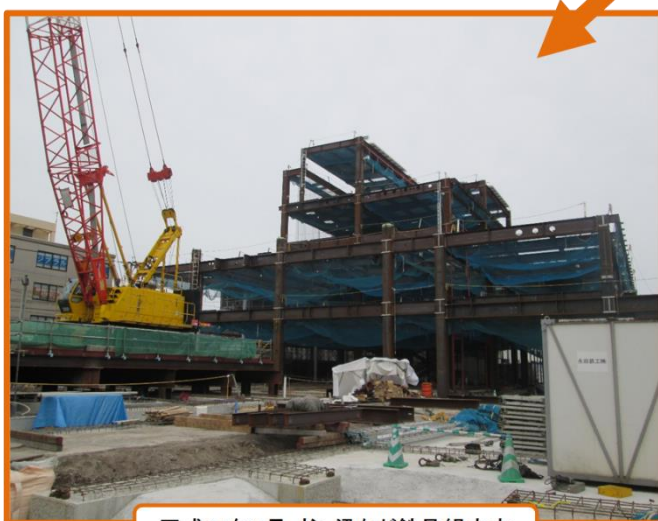
平成31年3月 柱・梁など鉄骨組立中
