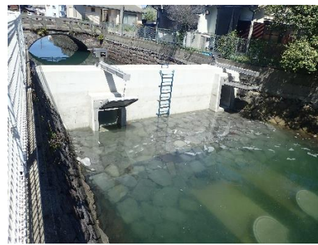
締切護岸完成 (十八銀行湊支店裏)
