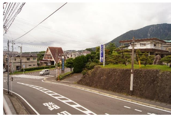
下川尻工区(島原病院入口付近)
