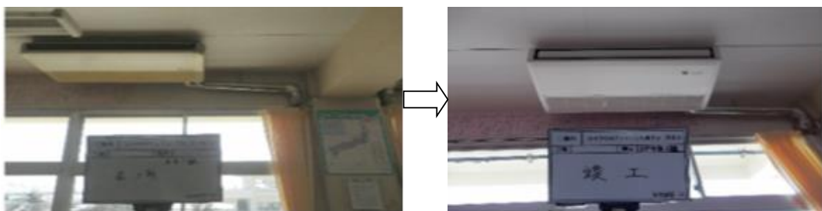
<第三中のエアコン更新工事>
