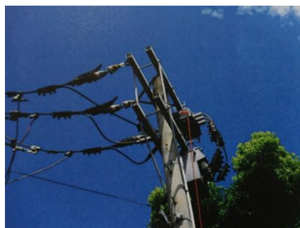
高圧区分開閉器取替
