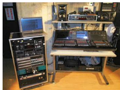
有明文化会館大ホール音響調整卓更新工事
