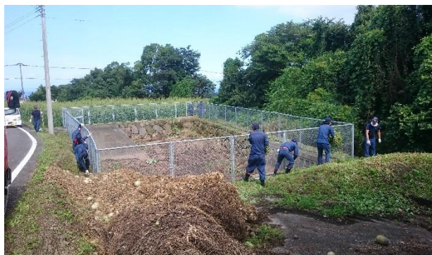
沈砂池の適正管理状況
