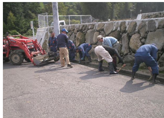
水路の泥上げ状況
