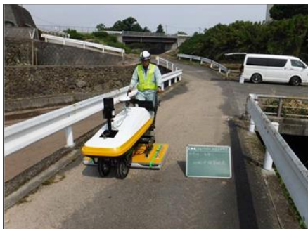
地中レーダ探査状況
