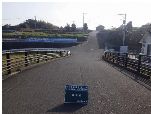
【区画線】 着工前
