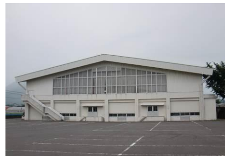
<有明農業者トレーニングセンター>
