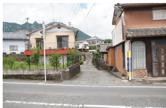
幅員が狭小な市道（南下川尻町）
