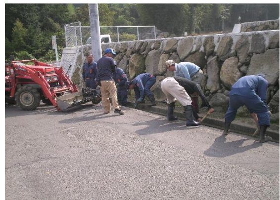
水路の泥上げ状況
