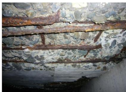
鉄筋露出腐食状況
