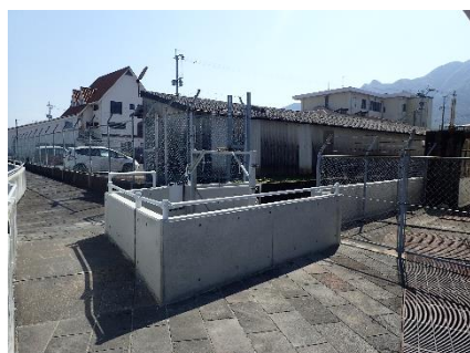
嵩上状況 (三会原土地改良区付近)
