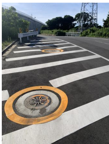
【消防団第 11 分団管轄耐震性貯水槽設置工事】
