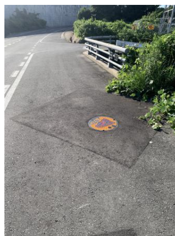
【小山新山線消火栓設置工事】
