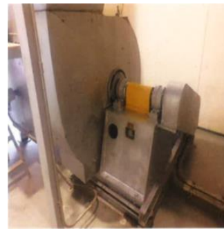
[排気ファンオーバーホール]
